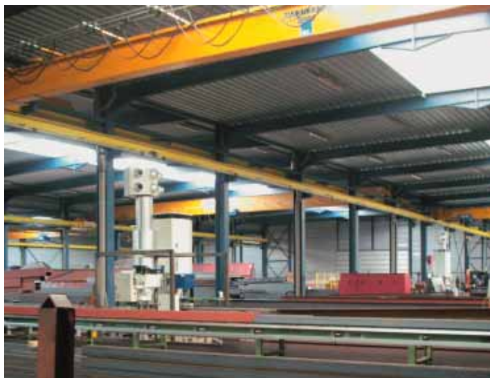
De laswerkzaamheden vinden plaats in een 10 meter hoge hal van 9.500 m 2 . De twee standalone-units staan hierin op vijftig meter van mekaar opgesteld
